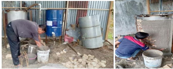
Gambar 9 pemasangan batu bata sebagai pelindung panas (install mesin arang)
