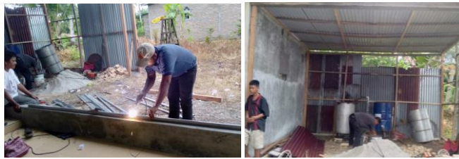
Gambar 7 pengelasan rangka pintu dan pembuatan atap rumah arang
