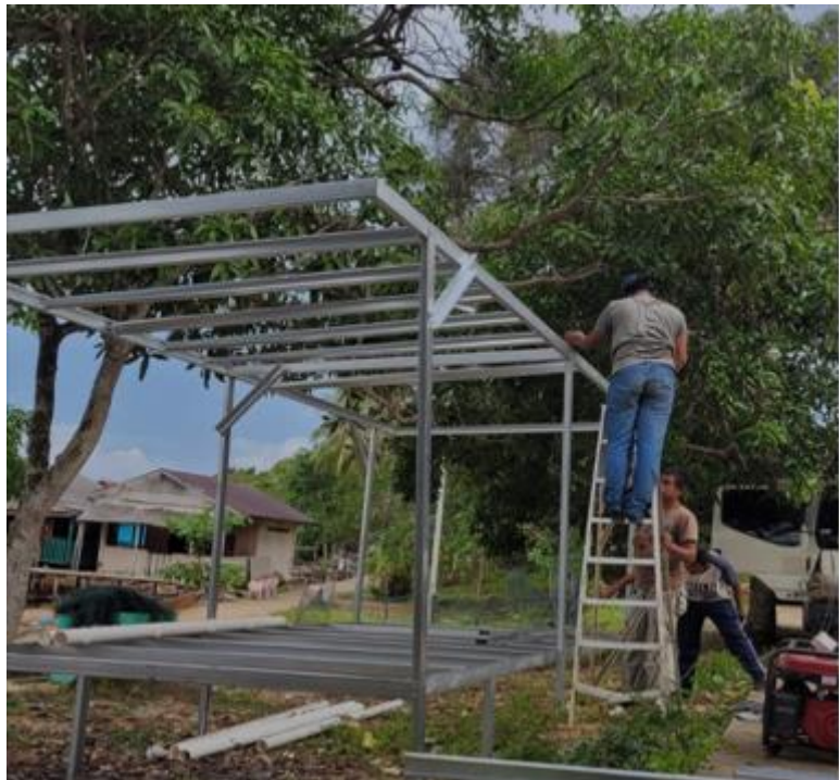
Gambar 3. Rangkaian kerangka baja ringan untuk kebun budi daya sayur hidroponik
