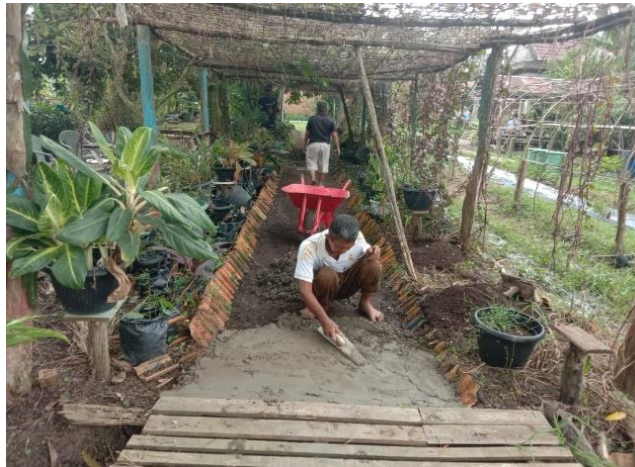
Gambar 4. Proses Perbaikan infrastruktur
