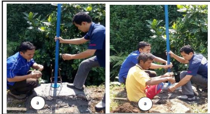
Gambar 5: (a) Pemasangan Tiang Lampu Tenaga Surya, (b) Pengecoran Pada Bagian Bawah
