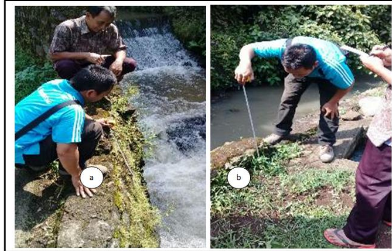
Gambar 2: (a) Survei Ketinggian (b) Penempatan Pompa Hidram di lokasi UKM
