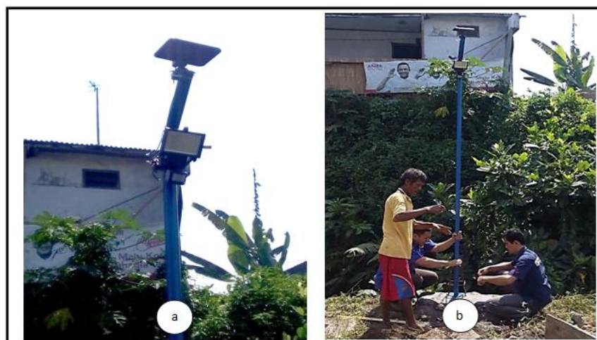
Gambar 6: (a) Pemasangan Box Lampu , (b) Pemasangan Tiang Lampu LED
