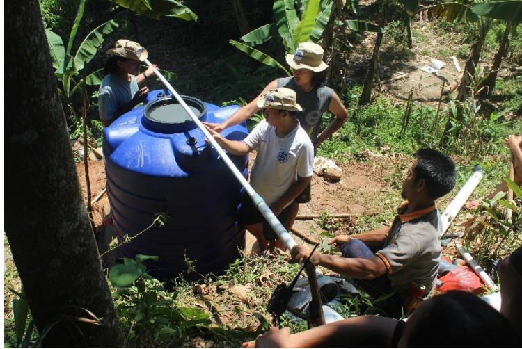
Gambar 4: Menyambungkan aliran air dari bak kontrol ke tangki air
