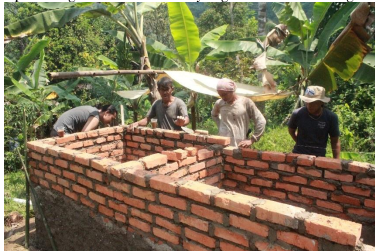
Gambar 3: Proses pembangunan bak kontrol yang dibantu oleh warga
